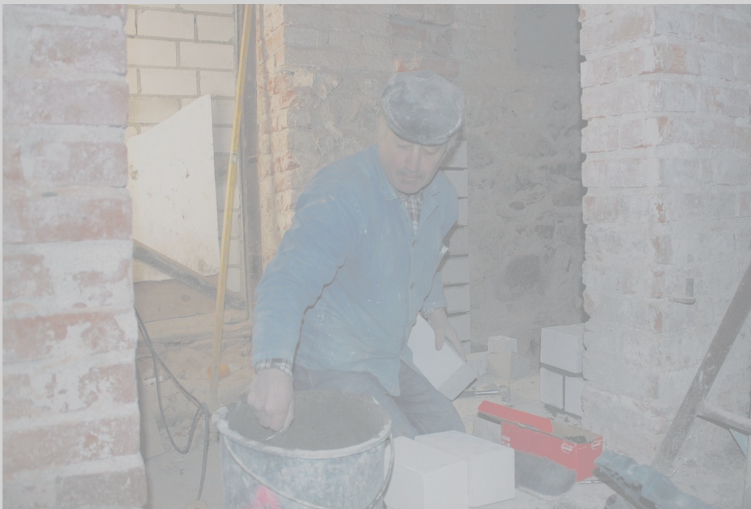
Alte Steine, neue Steine: Alfred Pichottky und seine Kollegen von der Neustrelitzer Baufirma Neuhaus arbeiten zurzeit unter anderem an den künftigen Sanitäranlagen im Telegrafenturm. FOTO: A. BRAUNS
